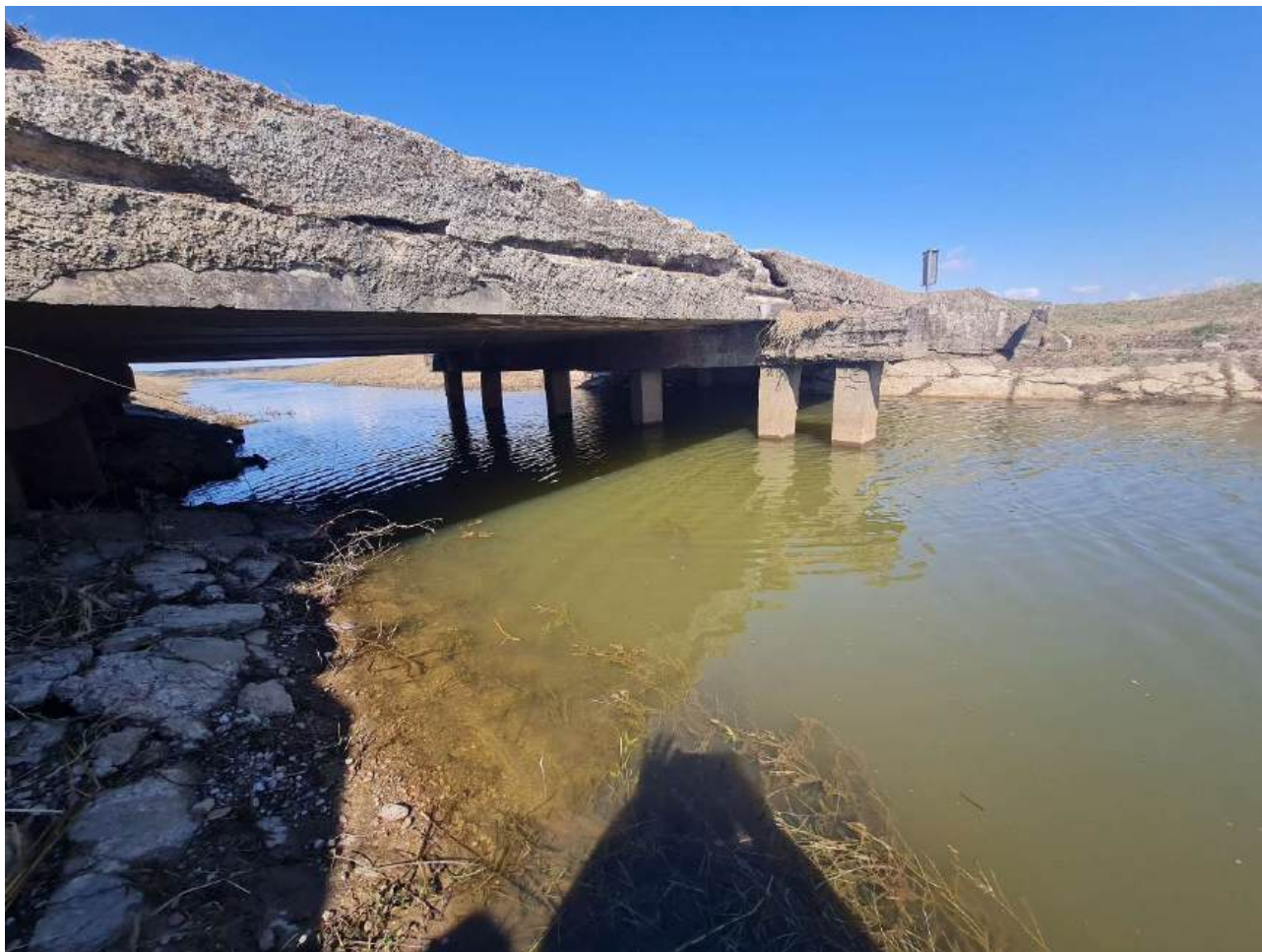
Pav. 6 Upės vagos po tiltu būklė
